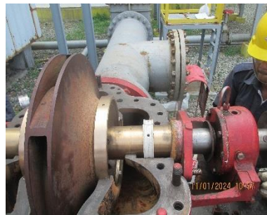
Gambar 4.12 Proses apply liquid gasket sebelum pemasangan gasket (Sumber : PT.Chandra Asri Pacific)
