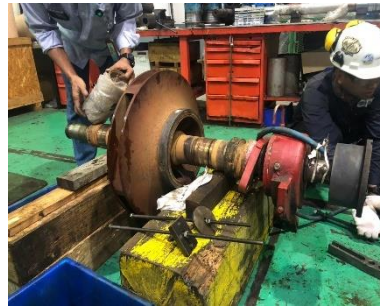
Gambar 4.9 Shaft sleeve baru akan dipasang (Sumber : PT.Chandra Asri Pacific)
