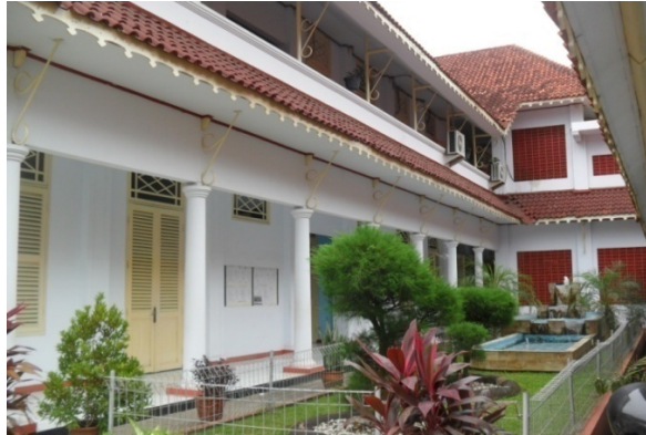
Gambar 4.6 Kantor DPKAD Kabupaten Serang Tampak Samping Sumber: Peneliti, 2011
