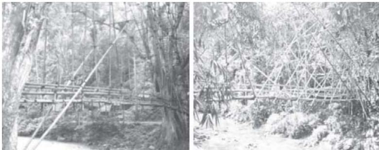
Gambar 6.8. Konstruksi Jembatan Bambu di Masyarakat Baduy
