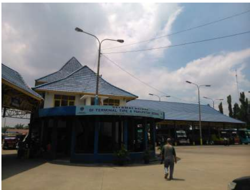
Gambar 4.9 Kondisi Terminal Pakupatan di Kota Serang
