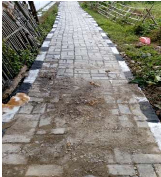
Gambar 4.12 Jalan lingkungan setelah di paving block
