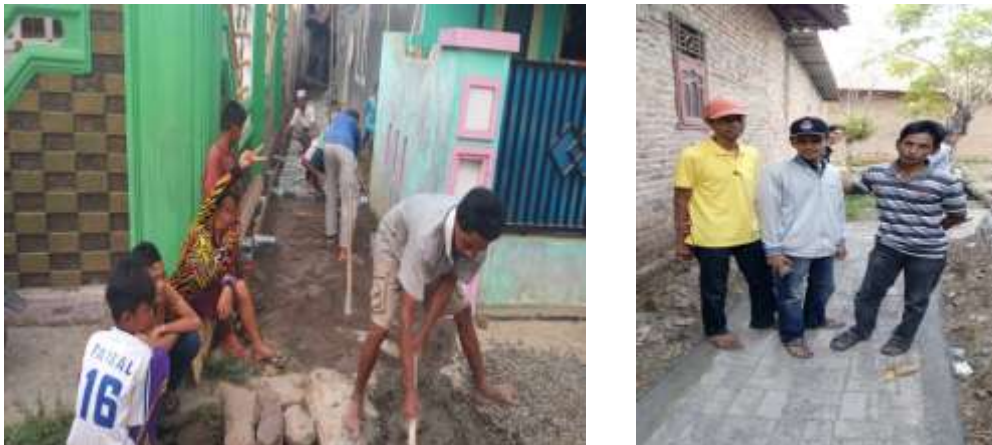
Gambar 4.16 Pembangunan paving block
