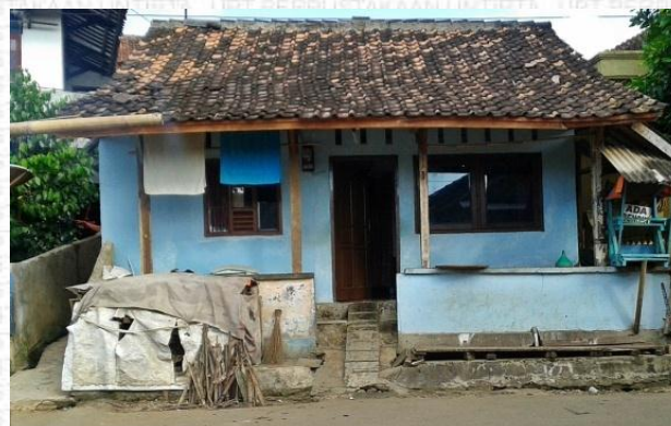
Foto rumah yang menerima BSM-SD yang dianggap tidak sesuai dengan peraturan program BSM-SD.
