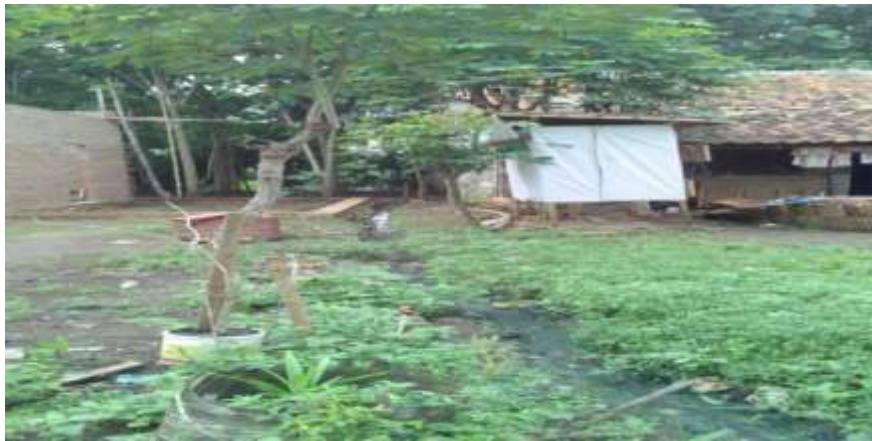
Gambar 1.4 Kondisi drainase di Kampung Tirtalaya RW 24 Kelurahan Serang Tahun 2016
