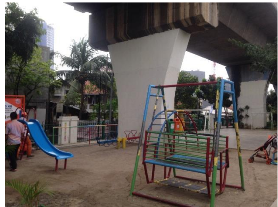
RPTRA Pintu Air Kel Pasar Baru yang dibangun di bawah jembatan PT KAI
