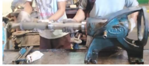
Gambar 4.8 Proses Pemasangan Shaft (Sumber : Dokumentasi Pribadi)
