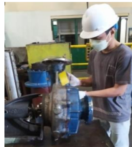
Gambar 4.9 Perakitan Komponen Pompa (Sumber : Dokumentasi Pribadi)
