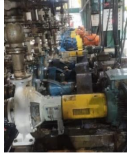
Gambar 4.2 Proses Pembongkaran Pompa
