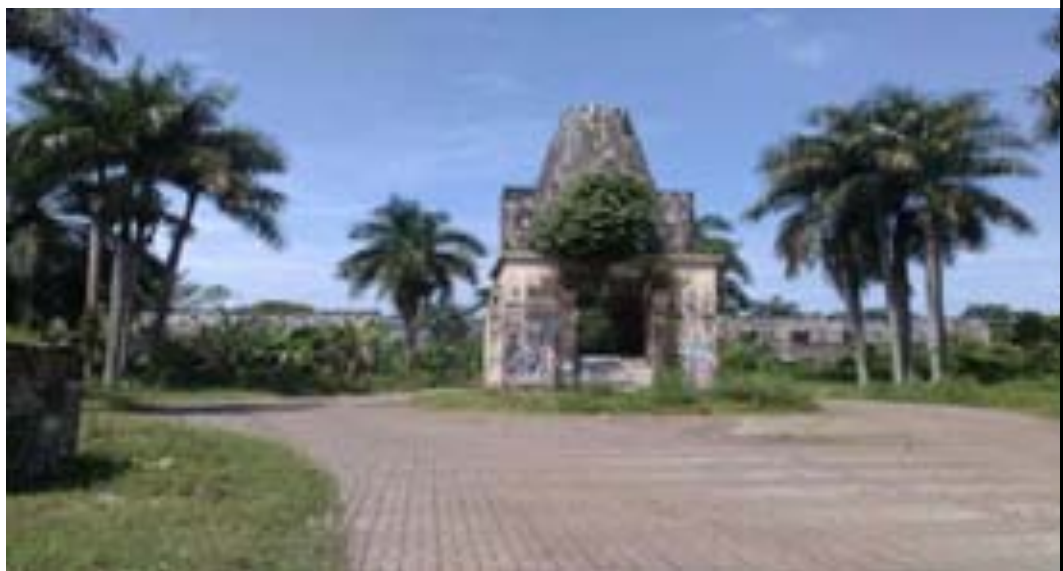
Kondisi gerbang utama perumahan yang terbengkalai
