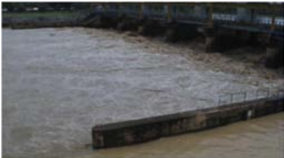
Bendungan Pamarayan Pada Level Awas
