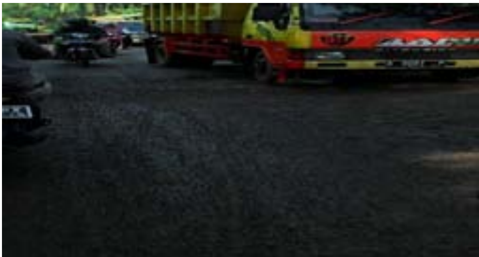
Kondisi Jalan di Desa Cimarga (08 Agustus 2015)
