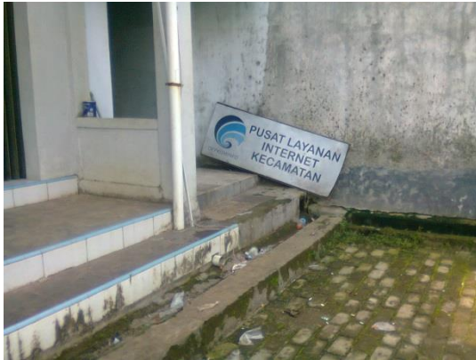
Tidak dipasangnya pelang PLIK
