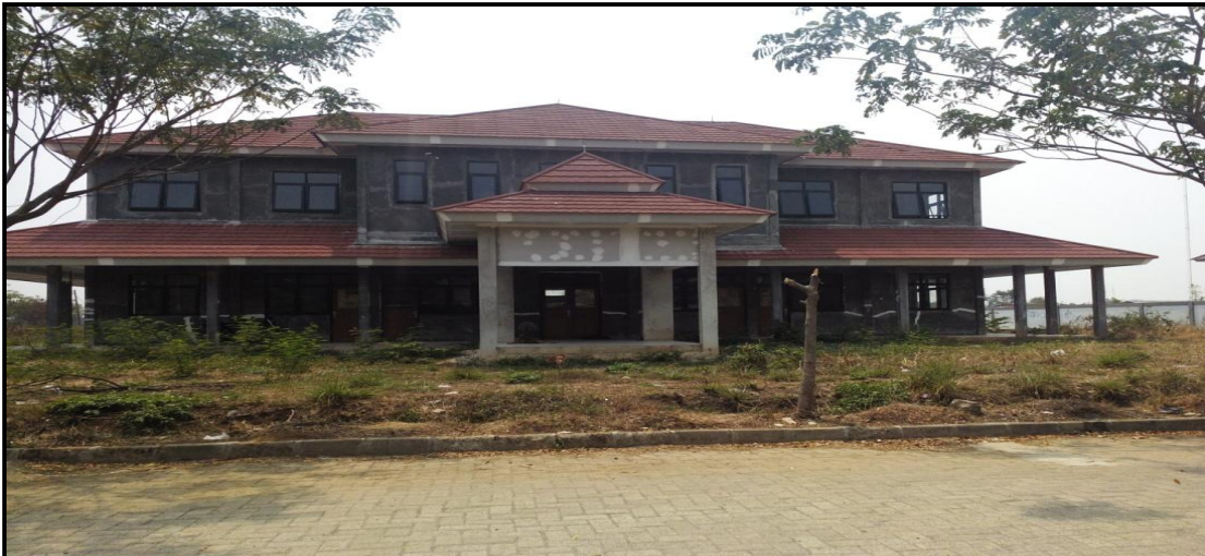
Gambar 1.1 Proyek Pembangunan Puskesmas Pasarkemis
