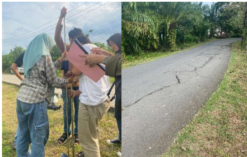
Gambar 1.1 Jalan Raya Sobang Desa Cimanis
