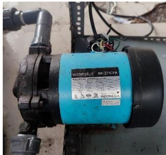
**Gambar 2.3** Pompa *Booster*
