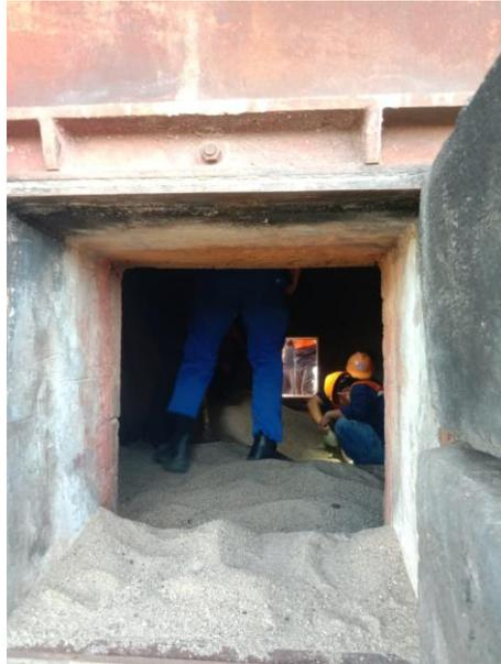
Pengecekan *bubble* pada pasir silica sebelum *start-up Boiler 3*
