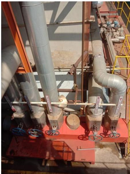
Jalur Uap *superheat* dari *Boiler 1*, *Boiler 2* dan *Boiler 3* yang berfungsi menggerakkan turbin
