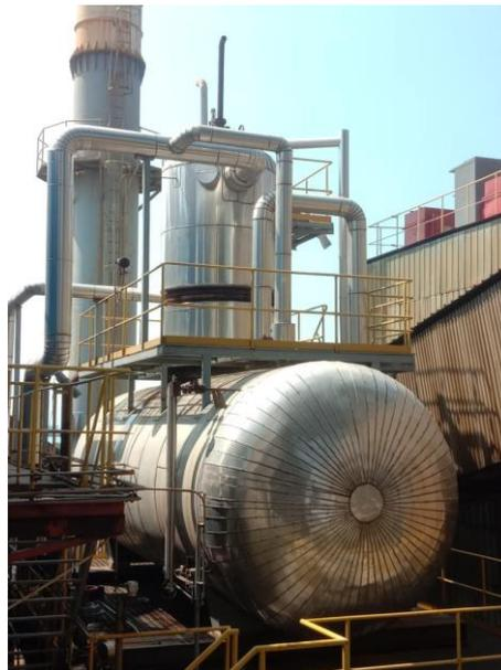
*Daerator* yang digunakan untuk kebutuhan *Boiler 2* dan *Boiler 3*
