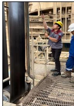
**Gambar 4.9** Menormalisasi Posisi *Belt* dengan Mengontrol *Chainblock*
