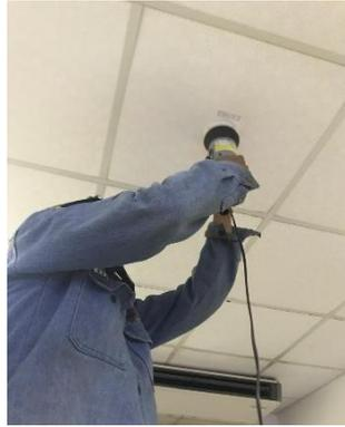
**Gambar 4.2** Pengujian *Heat detector* dan *Smoke Detector*
