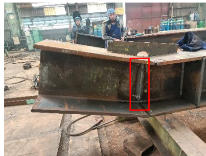
Gambar 4.5 Area pengelasan yang dilakukan proses NDT (Sumber : PT. IHI Power Service Indonesia)
