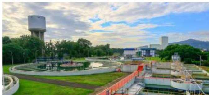
Gambar 2.9 Instalasi Pengolahan Air (IPA) Krenceng (Sumber: PT Krakatau Tirta Industri)
