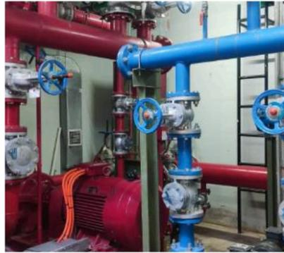
**Gambar 2.1** Pipa dan pompa air bersih
