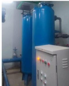
**Gambar 2.4** Filter untuk air hujan
