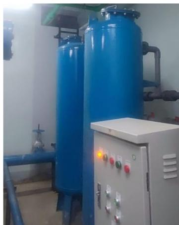
**Gambar 2.4** Filter untuk air hujan
