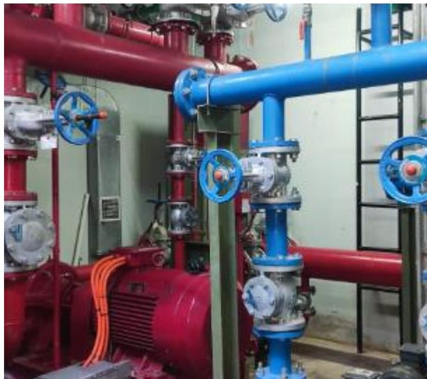
**Gambar 2.1** Pipa dan pompa air bersih
