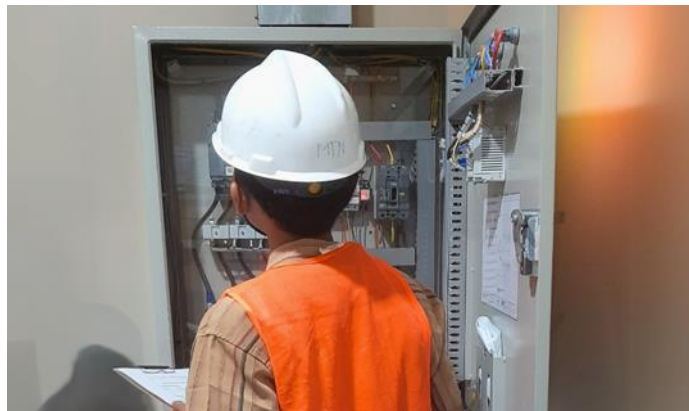
Gambar 4.1 Pengambilan Nilai Beban Daya pada Panel SDP DC
