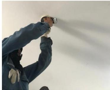
**Gambar 4.17** Pengetesan *Smoke Test*
