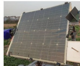
(d) Penutupan 1 panel
