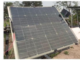
(d) Penutupan 1 panel
