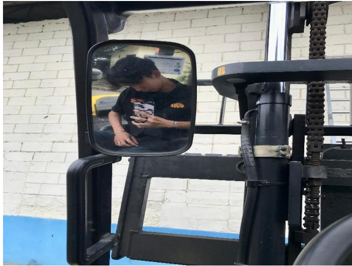
Proses pemasangan CCTV dengan menggunakan Forklift
