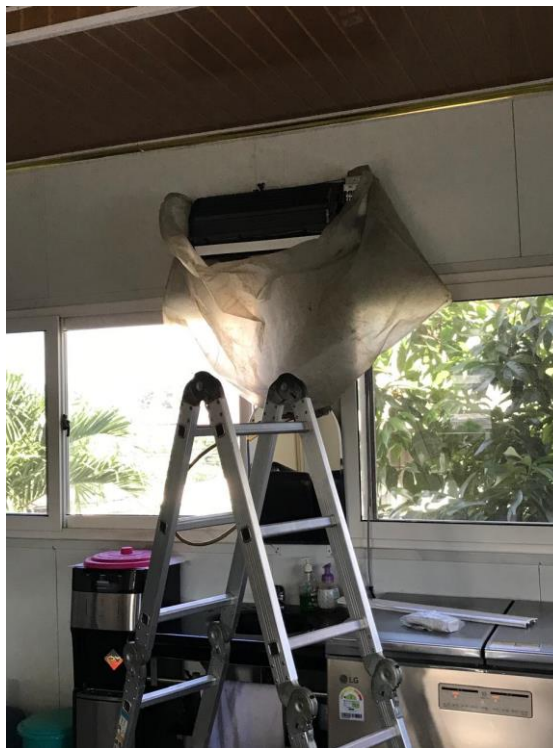
Pembersihan AC di mess pada PT. Geum Cheon Indo
