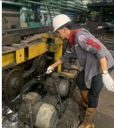
Gambar 4.20 Pengecekan Kondisi Gear dan Chain (Sumber : PT Krakatau Baja Konstruksi)
