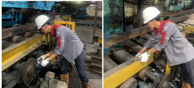
Gambar 4.16 Pengecekan Bolt dan kondisi Roll Table Interface (Sumber : PT Krakatau Baja Konstruksi)
