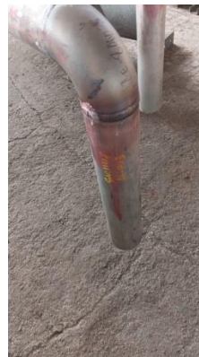
Gambar 4.3 benda kerja setelah penetrant berlebih dibersihkan
