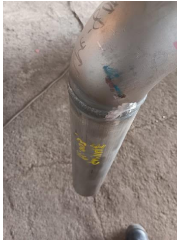
Gambar 4.1 benda kerja setelah disikat
