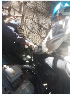
Gambar 4. 7 Proses menaruh plat untuk penyeimbang
