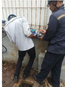
Gambar 4. 6 Proses Pemasangan Flowmeter
