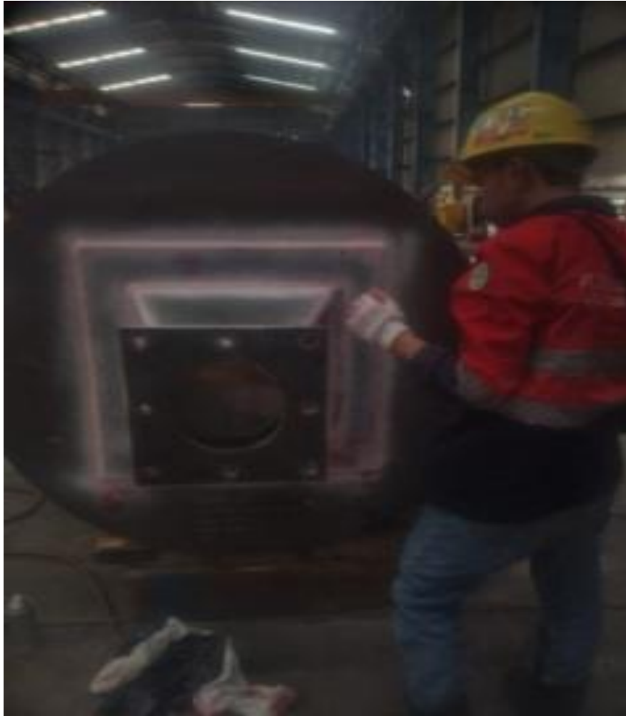
Gambar 5.12 Penyemprotan Developer Pada Sambungan Pengelasan.
