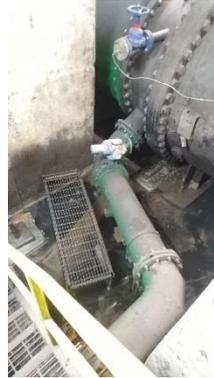
**Gambar 4.5** Memeriksa kebocoran fluida pada *line backwash debris*
