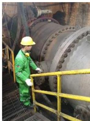
**Gambar 4.4** Memeriksa kebocoran fluida pada *body, flange*, dan baut *debris*
