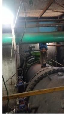
**Gambar 4.8** *Tightening* dan memeriksa kelengkapan baut dan mur pengikat *debris*
