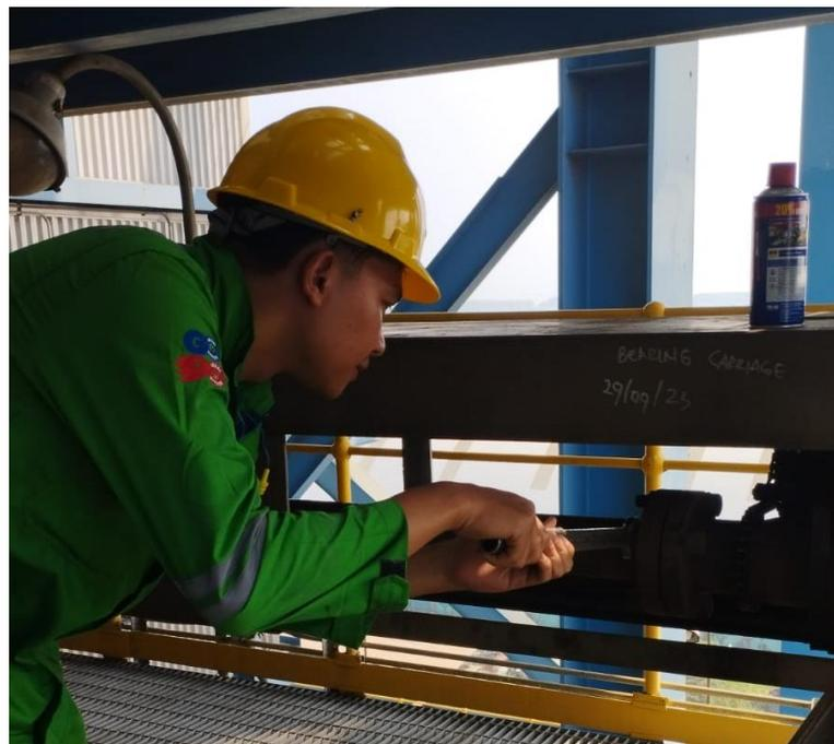
**Gambar 4.8** Pemeriksaan *Bearing Carriage* dan *Gearbox*
