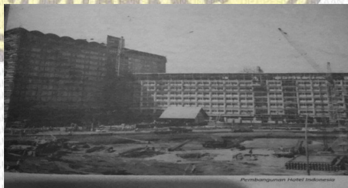
Gambar. 4 Pembangunan Hotel Indonesia
