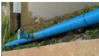
Gambar 3.5 Jaringan Pipa Transmisi
