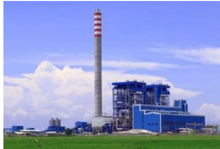
Gambar 2.1 PLTU Banten 2 Labuan PGU (Sumber: Perusahaan, 2023)
