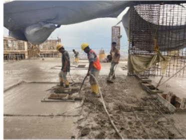
Gambar 5.11 Pengecoran Pelat Lantai Proyek Hotel
