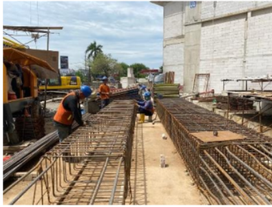
Gambar 5.1 Perakitan Kolom Proyek Hotel
