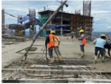
Gambar 5.8 Pengecoran Balok Proyek Hotel
