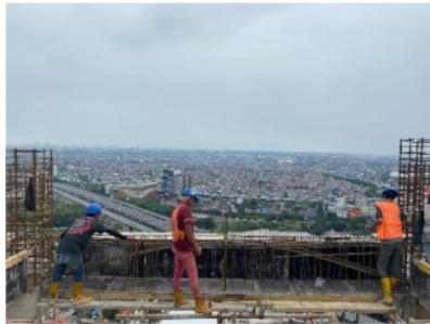
Gambar 5.7 Pembesian Balok Proyek Hotel
