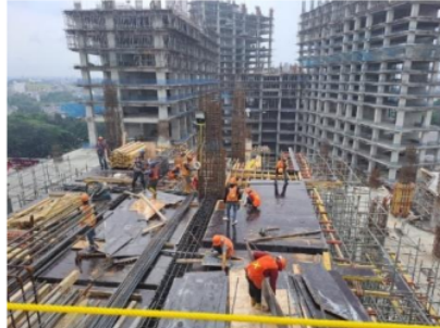
Gambar 5.9 Pemasangan Bekisting Pelat Lantai Proyek Hotel
