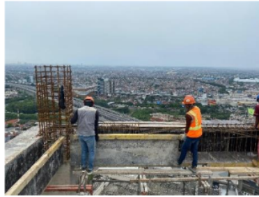
Gambar 5.6 Pemasangan Bekisting Balok Proyek Hotel
