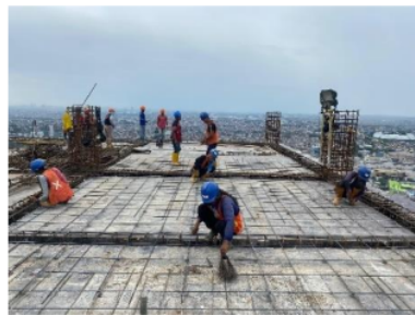
Gambar 5.10 Pembesian Pelat Lantai Proyek Hotel
