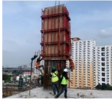
Gambar 5.3 Pemasangan Bekisting Kolom Proyek Hotel
