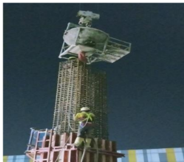
Gambar 5.5 Pengecoran Kolom Proyek Hotel
