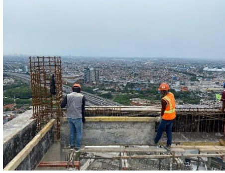
Gambar 5.6 Pemasangan Bekisting Balok Proyek Hotel
