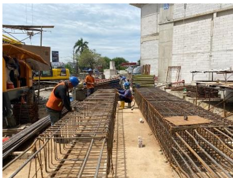
Gambar 5.1 Perakitan Kolom Proyek Hotel
