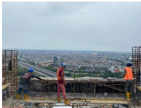
Gambar 5.7 Pembesian Balok Proyek Hotel
