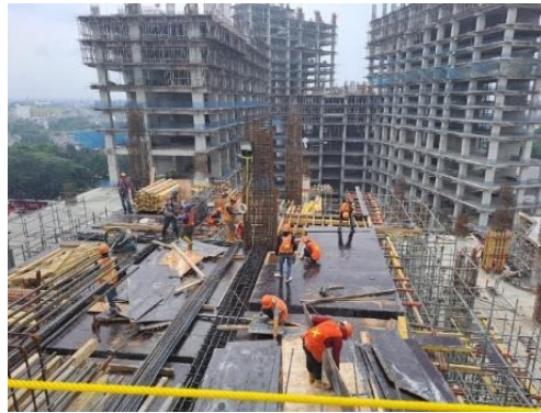
Gambar 5.9 Pemasangan Bekisting Pelat Lantai Proyek Hotel
