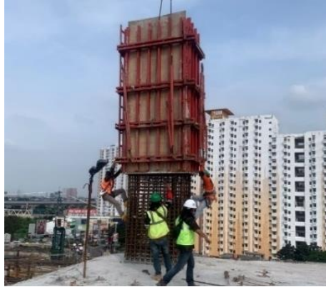
Gambar 5.3 Pemasangan Bekisting Kolom Proyek Hotel
