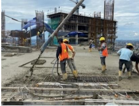
Gambar 5.8 Pengecoran Balok Proyek Hotel
