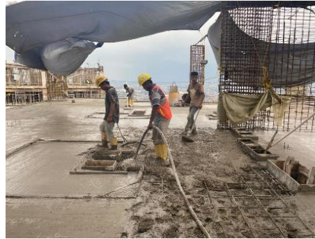
Gambar 5.11 Pengecoran Pelat Lantai Proyek Hotel
