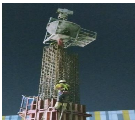
Gambar 5.5 Pengecoran Kolom Proyek Hotel
