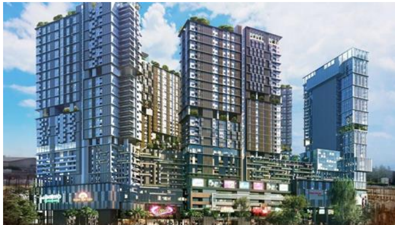
Gambar 4.1 Proyek Pembangunan Hotel Bekasi Mixed Use Development
