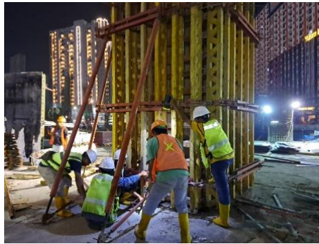
Gambar 5.4 Pengecekan Vertikal Kolom Proyek Hotel
