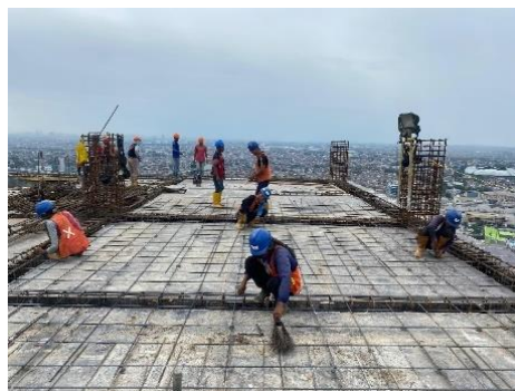
Gambar 5.10 Pembesian Pelat Lantai Proyek Hotel
