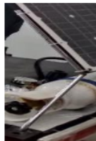
Gambar 4.1 Tiang Alluminium Pada Solar Panel
