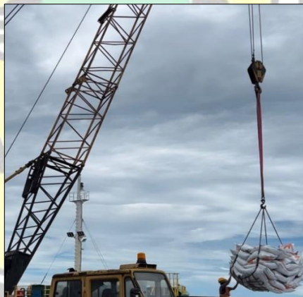
Gambar 9. Pemasangan sachles dan wire rope sling crane
