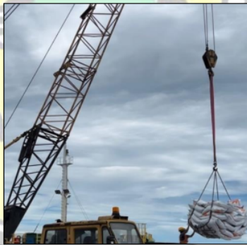
Gambar 9. Pemasangan sachles dan wire rope sling crane
