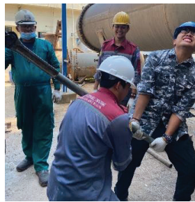
Gambar A.2 Pelepasan Baut pada Heat Exchanger
