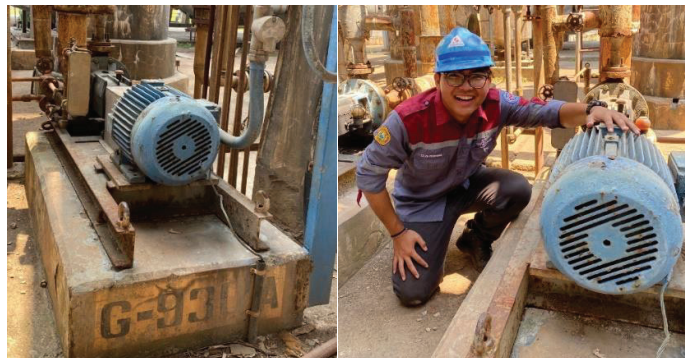
Gambar 4.12 Pemasangan kembali pada Pompa Sentrifugal G-930 A
