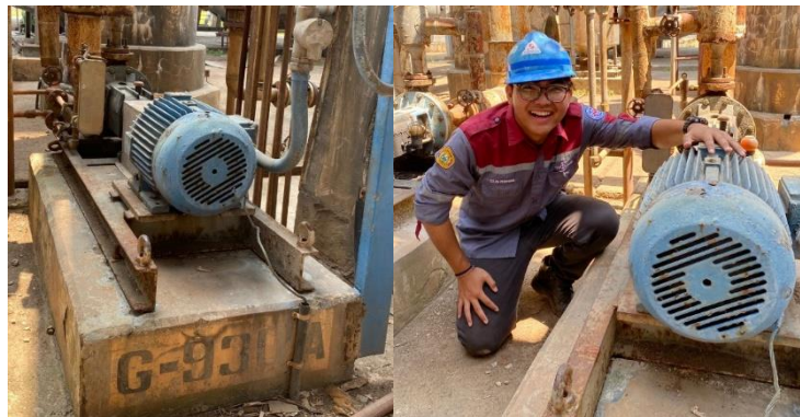
Gambar 4.12 Pemasangan kembali pada Pompa Sentrifugal G-930 A
