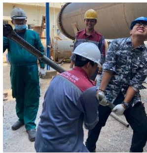
Gambar A.2 Pelepasan Baut pada Heat Exchanger
