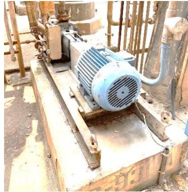
Gambar 4.1 Pompa Sentrifugal G-930 A
