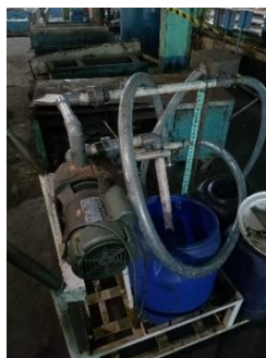
Gambar 4.13 Alat untuk flushing
