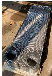
Gambar 4.5 Penggantian Pelat pada PHE (E-321A)
