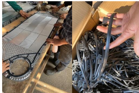
Gambar 4.8 Pemasangan Gasket pada PHE (E-321A)
