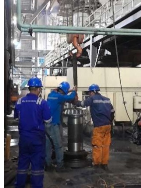
Gambar 4.6 Memasang Bearing Bagian Bawah (Sumber: Dokumen Pribadi)
