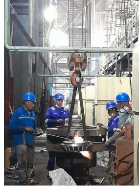
Gambar 4.8 Panaskan Bearing Atas
