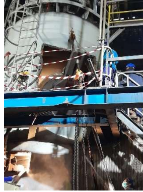
Gambar 4.2 Persiapkan Chain Block Mengarah Keluar (Sumber: Dokumen Pribadi)
