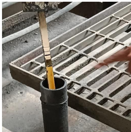
Gambar 5. 8 Pengecekan Level Oli Guide Bearing
