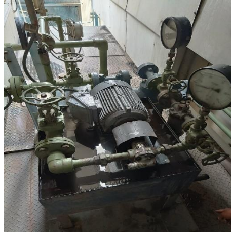
Gambar 5. 9 Pengecekan Level Air pada Pompa Guide Bearing
