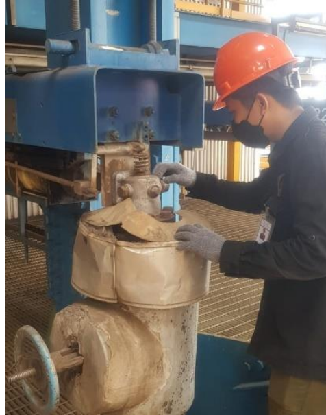
Gambar 4.12 Pemeriksaan pada valve
