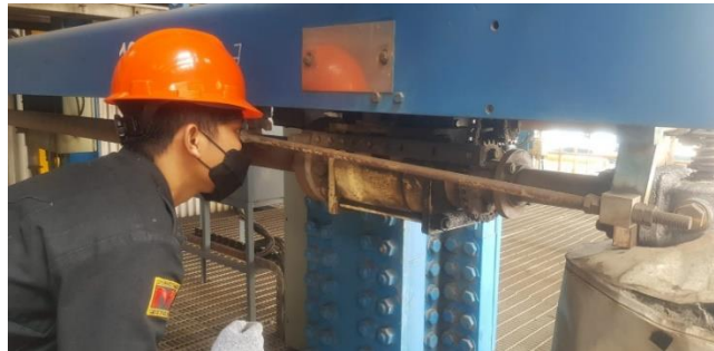
Gambar 4.15 Pemeriksaan Kebocoran dan Gear Box
